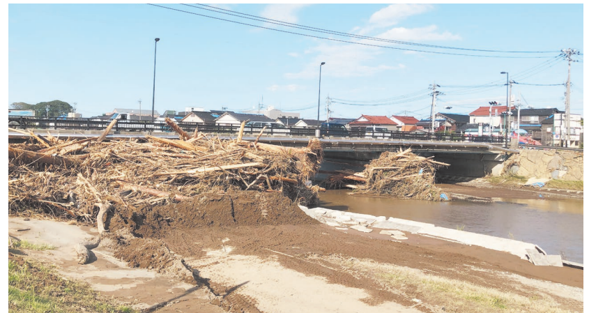
2024年9月21日の能登半島豪雨後の輪島市役所前の状況
